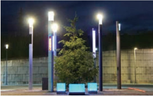
防犯カメラや冷却ミストも1本の柱に集約できる多機能型街路灯「スマートポール」
